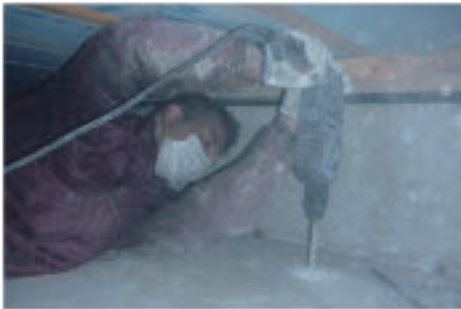
削孔状況 16mm振動ドリル
