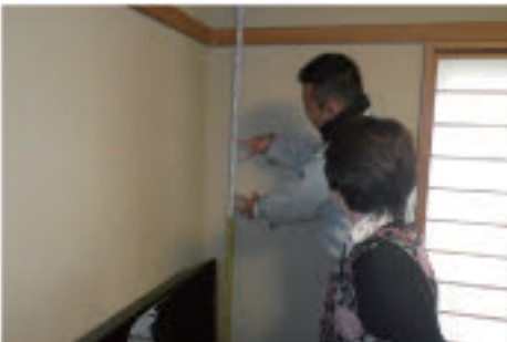
お施主様立会にて最終確認、室内の床レベルを確認
