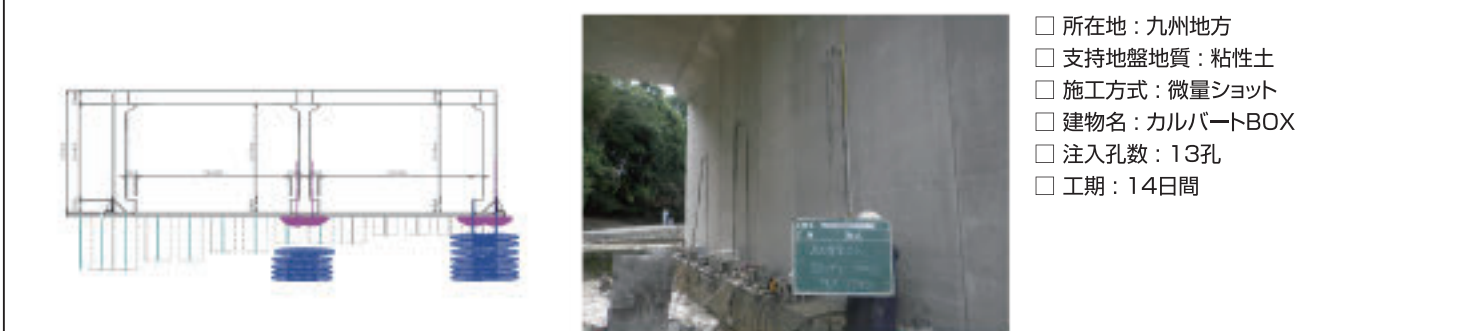
■ カルバートBOX新設工事に伴う沈下修正及び深層部強化注入工事
