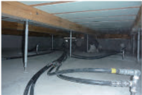
注入管設置、配線、配管状況
